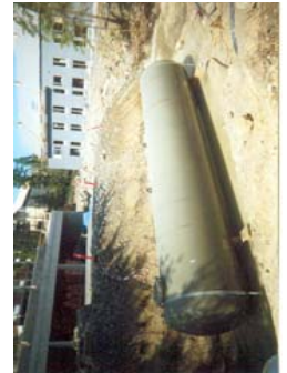
Forankret gasstank, klar for overdekking
